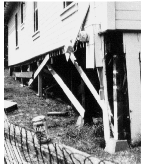
Figura 18 – La base o poste de cimiento debajo de esta casa se deslizó debido a un terremoto reciente.
