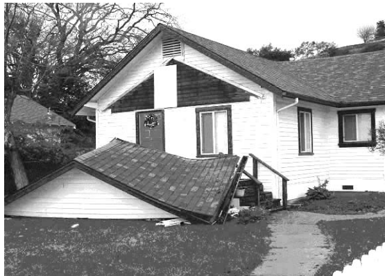
Figura 6 – Terremoto de San Simeon, Dic. 22, 2003 La entrada derrumbada no estaba debidamente conectada a la residencia.
