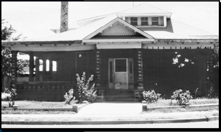
Antes del Terremoto
