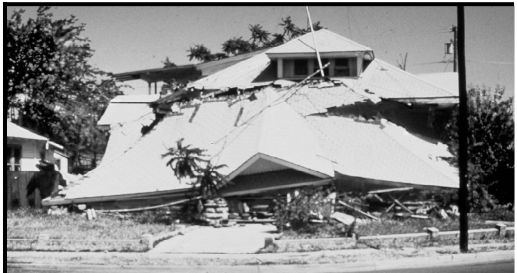
Daños por temblores adicionales
