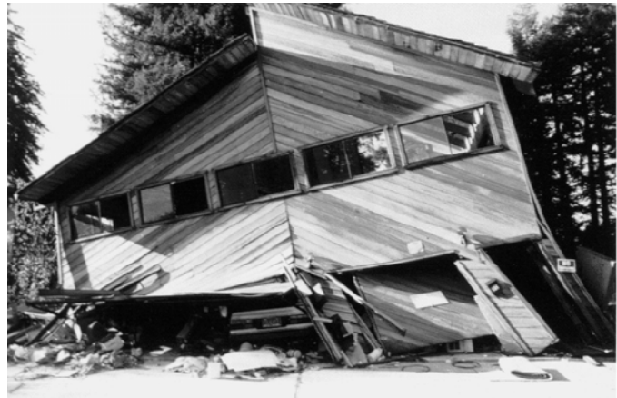
Figura 29 – Esta casa de montaña fue construida sobre un garaje y las paredes no fueron lo suficientemente fuertes para soportar un terremoto.
