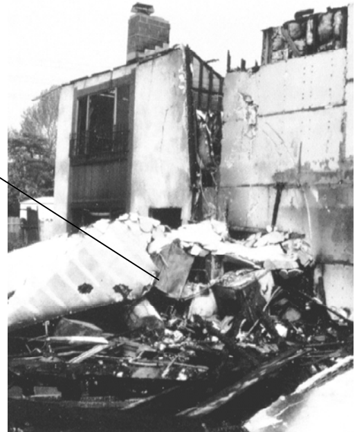
Figura 10- El calentador de agua sin refuerzo en esta casa se cayó durante un terremoto; el incendio que resultó de esto destruyó la casa.
