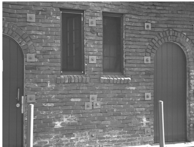
Figura 28 – Pared de mampostería sin refuerzo, atornillada a un marco de acero interior.
