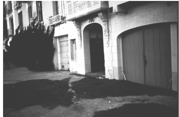
Figura 40 - Terremoto de Loma Prieta, Octubre 17, 1989. La expansión lateral, las arenas movedizas en suspension causaron daños en el Distrito de Marina de San Francisco, a 60 millas de distancia del epicentro.
